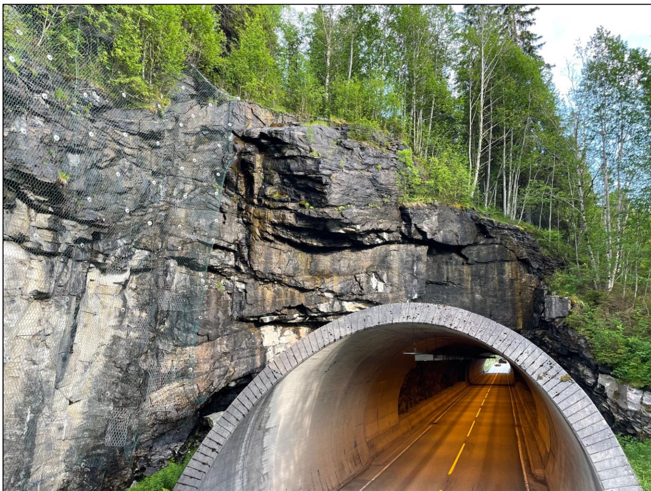
Foto 1. Oversikt portalområde, påhuggsflate og forskjæring i nord. Forskjæringen er sikret med bolter og sikringsnett.
