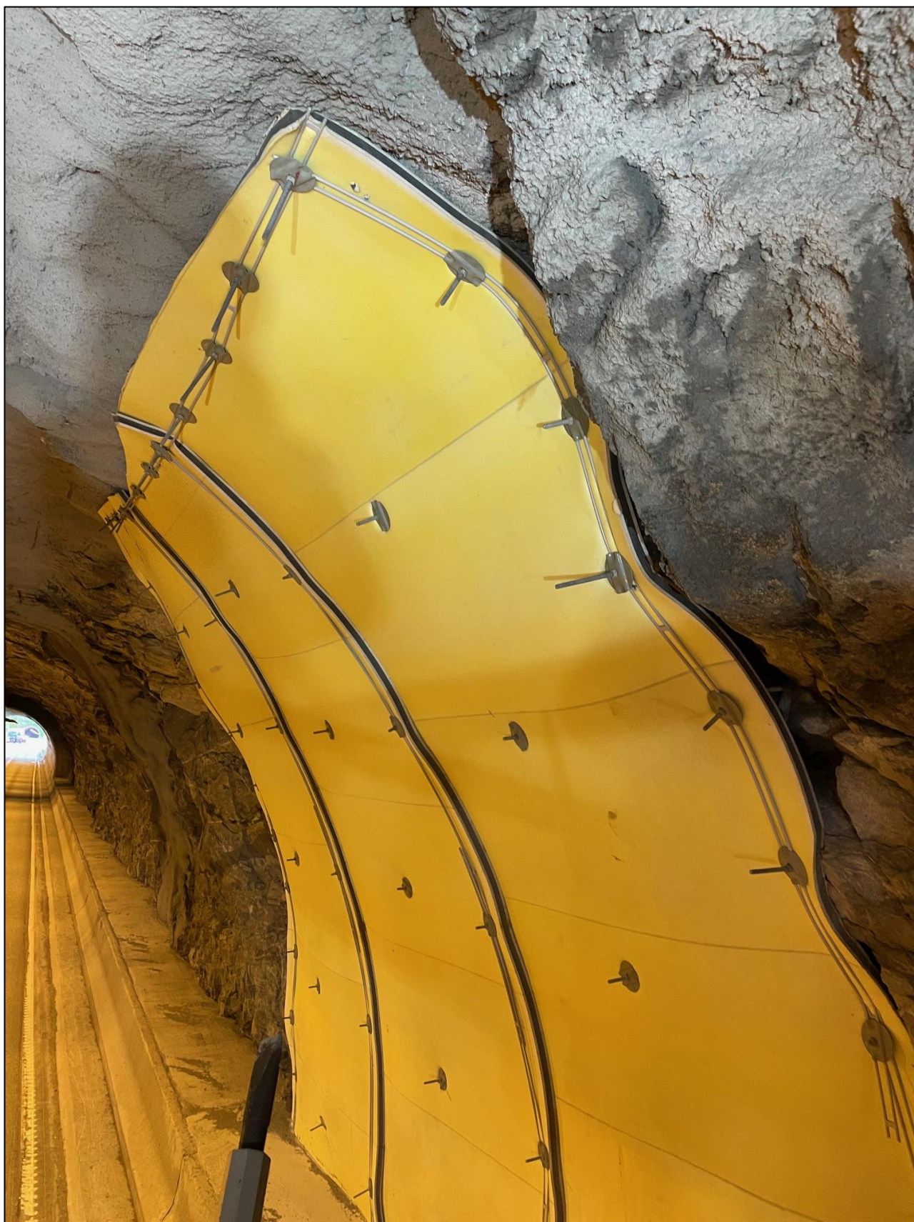
Foto 7. Åpent PE-skum. Pel 150-160, venstre side. Det anbefales å påføre brannsikret sprøytebetong.
