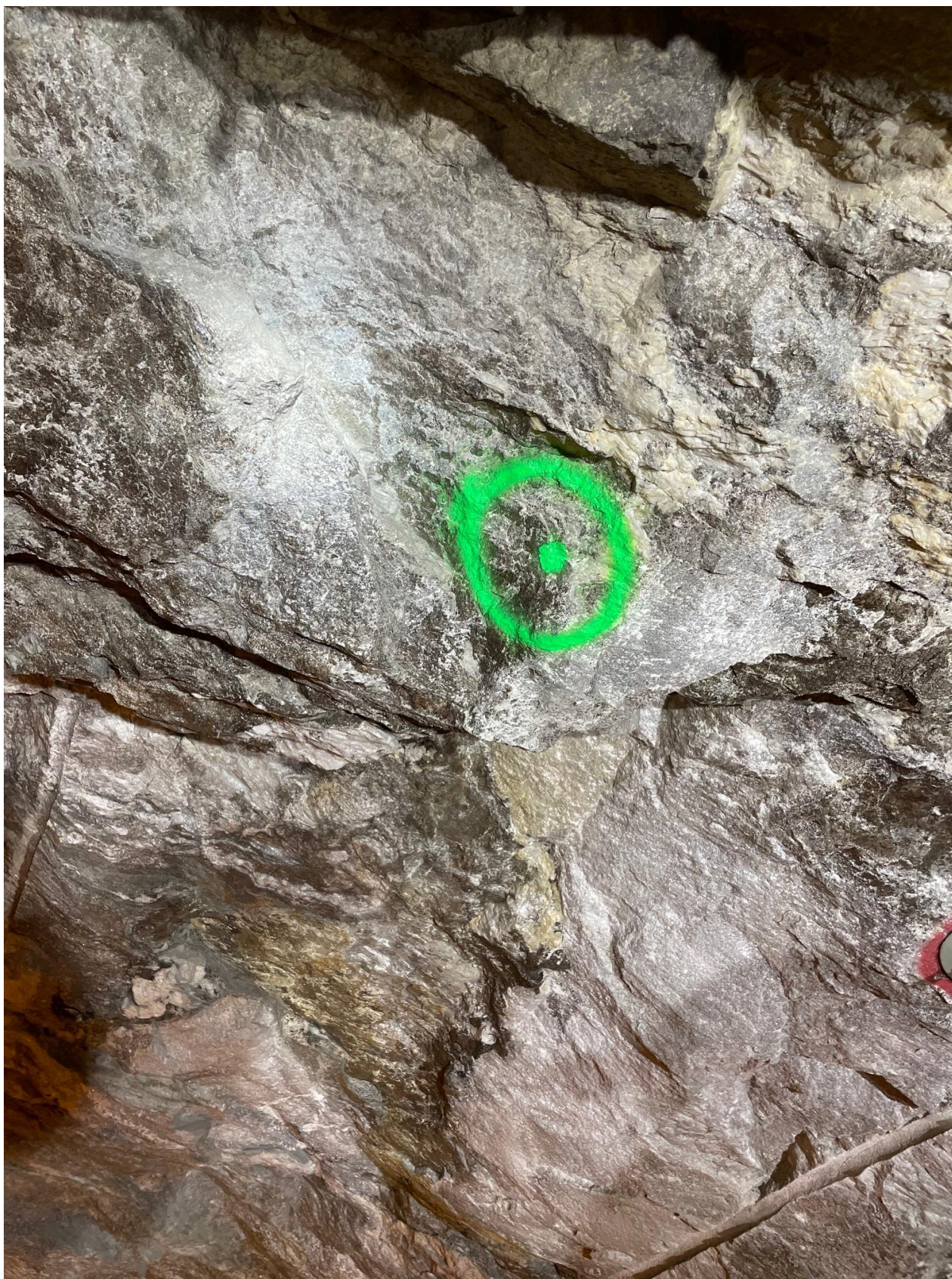
Foto 9. Tiltak for boltesikring, pel 122.
