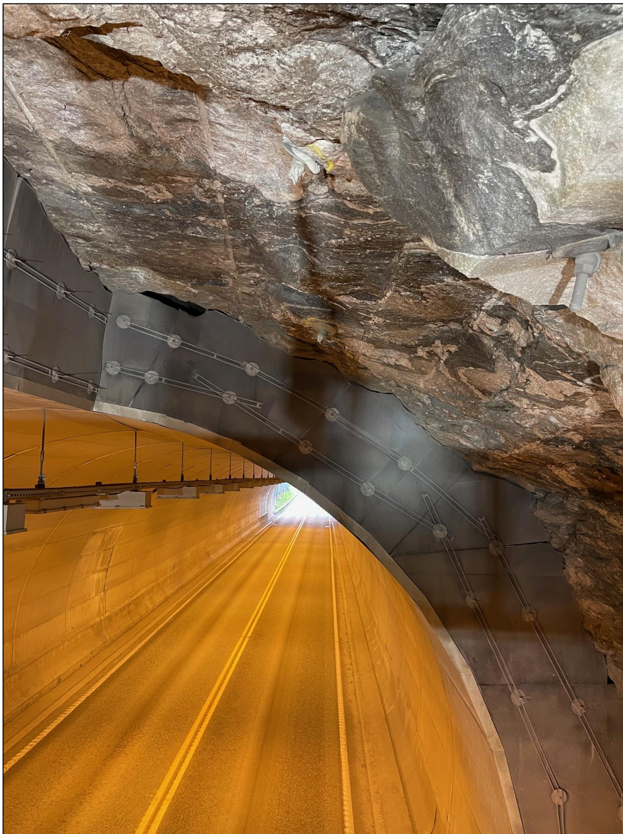
Foto 10. Overgang berg til miljøhvelv mot tunnelportal i sør.
