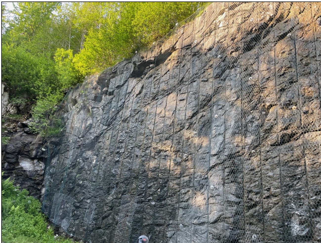
Foto 5. Tunnelportal sør, høyre side av forskjæringen. Sikret med spredte bolter og sikringsnett.
