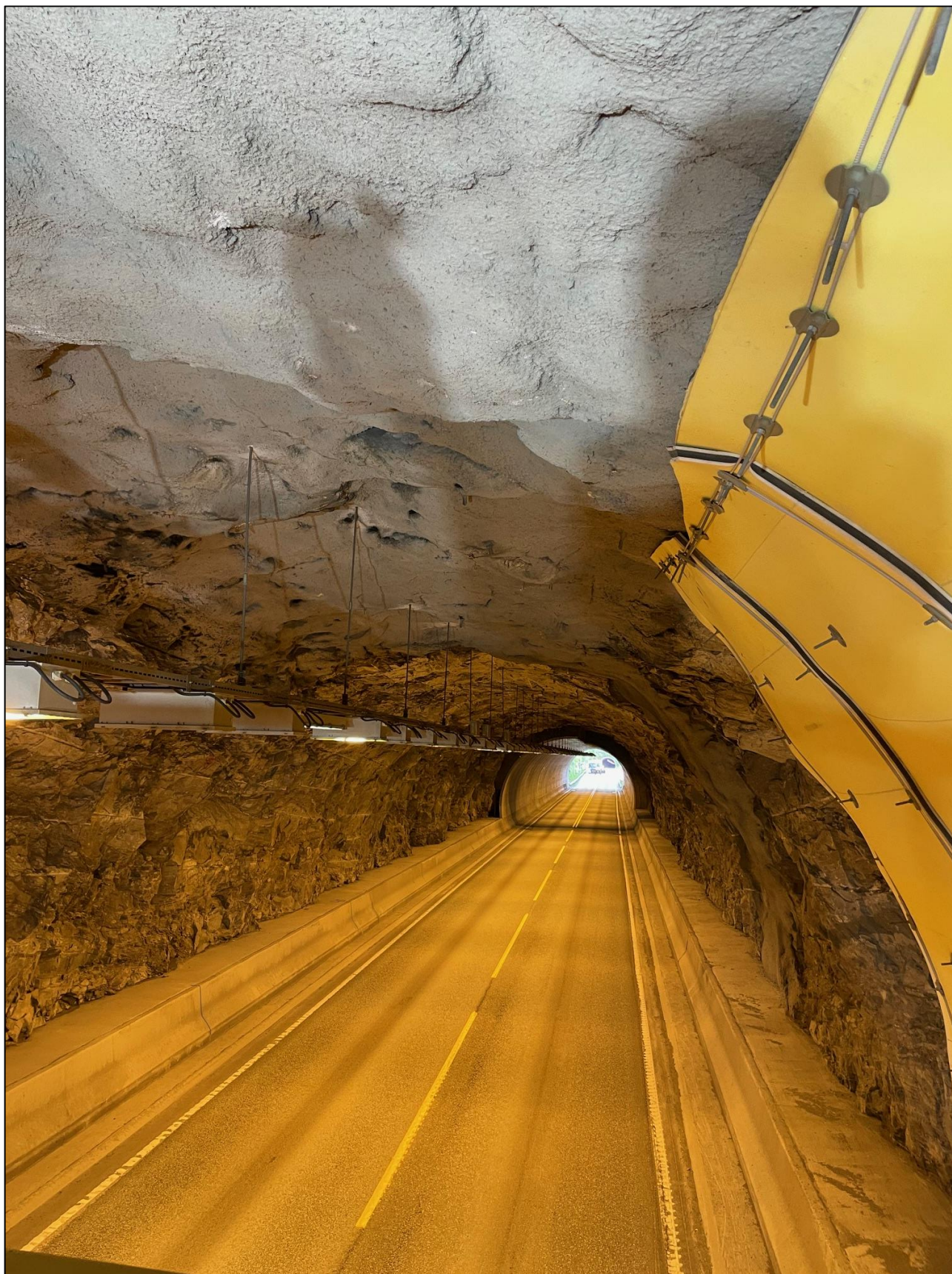
Foto 8. Oversiktsbilde over generelle forhold i tunnelen. Partier med bart berg, sprøytebetongsikring, brannsikret PE-skum og åpent PE-skum.
