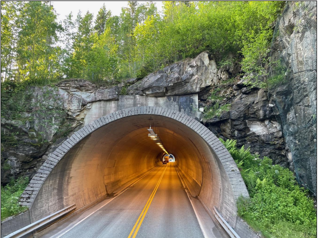
Foto 4. Tunnelportal og påhuggsflate i sør. Over tunnelportalen er det sikret med betongmur under overheng.
